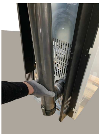
Fig. 41 - Insert pipe d.80 mm
