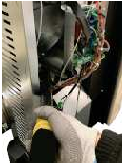
Fig. 83 - Room fan cleaning
