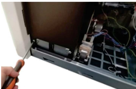
Fig. 101 - Room fan cleaning
