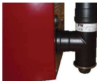
Fig. 89 - Fume conduit cleaning
